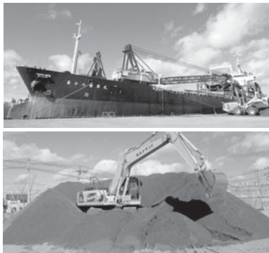
上は石巻港における荷揚げ。下はストックヤード
